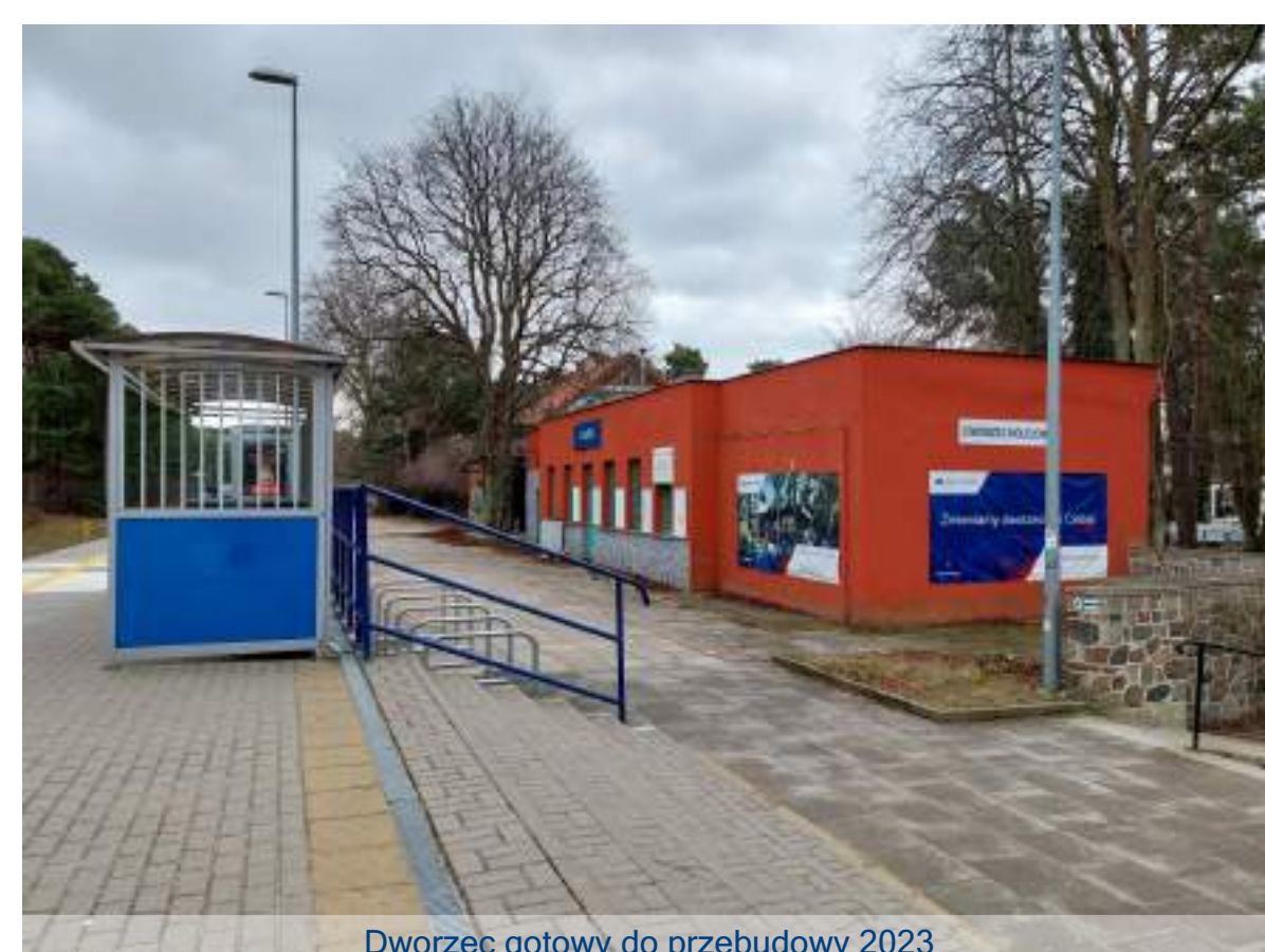
Dworzec gotowy do przebudowy 2023
