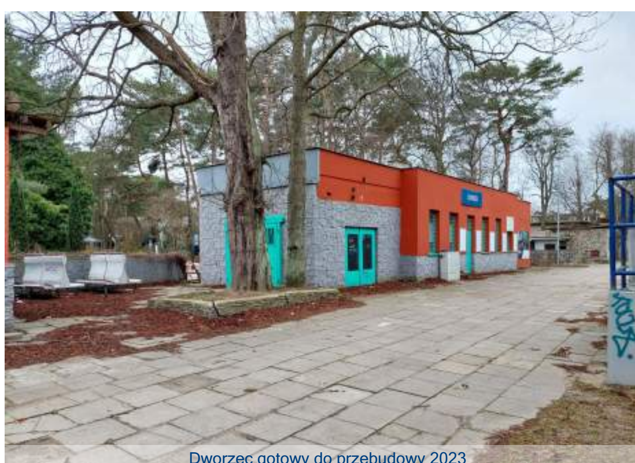
Dworzec gotowy do przebudowy 2023
